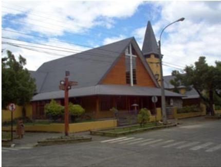
Su volumetría es muy sencilla, en ella destaca la gran estructura de techumbre de color gris. Posee una planta rectangular, recortada, la gran cubierta es intersectada por otra de menores dimensiones conformando un corredor que cumple la función de acceso.
