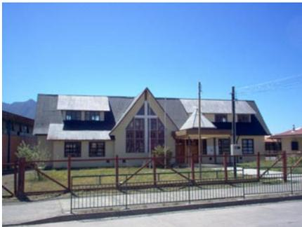
Se compone de un volumen ortogonal de dos pisos, techado a dos aguas, del cual nacen frontones que jerarquizan la fachada. Su arquitectura completamente en madera, presenta características tradicionales de la arquitectura de los colonos alemanes, destaca la fachada, llena de simbolismos, por ejemplo la cruz central que aparece en el frontón que nace del volumen principal, acompañada de doce cruces que simbolizan los doce apóstoles.
